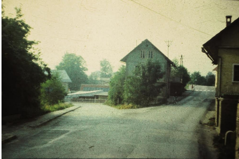
Kapusova hiša – pred rušenjem, 1985 Vir: arhiv Vlado Žvegelj
