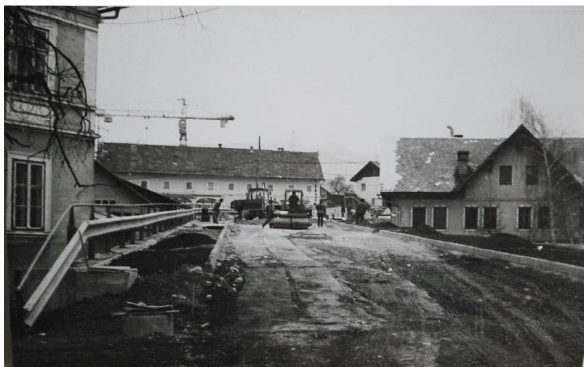
Kunčičeva hiša pri gradnji klančine proti postaji, 1985 Vir: arhiv Vlado Žveglj
